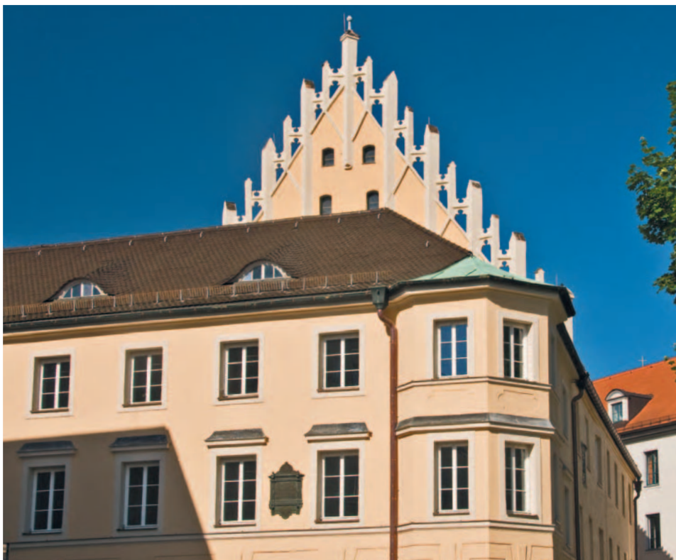
Blick auf die Ostfassade
