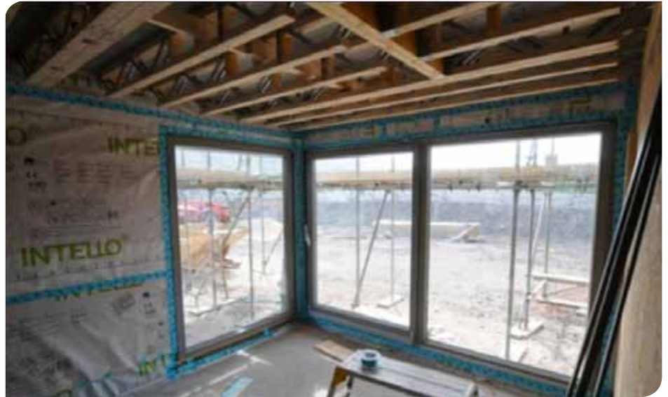
Figure 7 Airtight membrane
